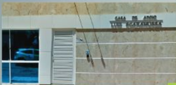
CASA DE APOIO
